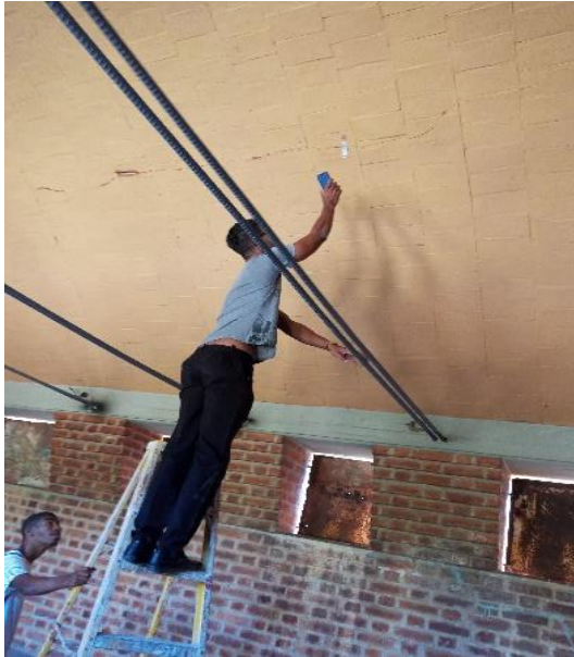
Fig 1. Ubicación de sensores de posición dentro del bloque 5
