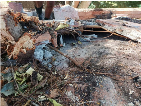
Zona 1: Radice che si è sviluppata sotto il primo strato di rasillas
