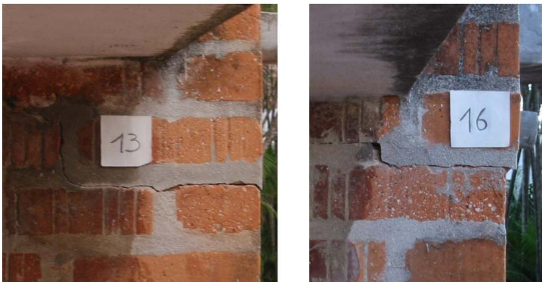
Fig. 42 – Particolare lesione nel contrafforte all’altezza in cui si inserisce la trave in cemento armato
