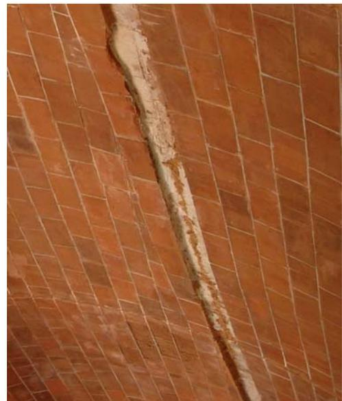
Fig. 35 – Lesione longitudinale all'intradosso della volta Fig. 14 Particolare della lesione longitudinale catalana
