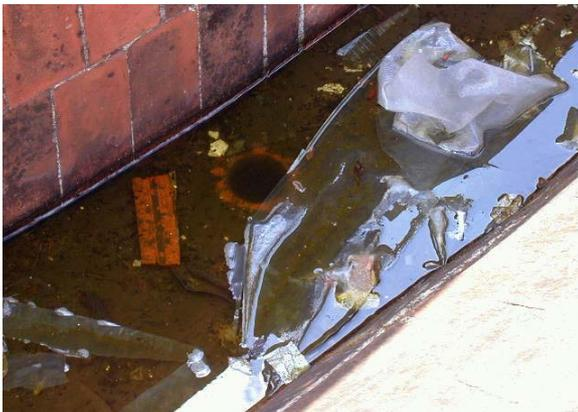
Fig. 18 – Ristagno delle acque meteoriche in corrispondenza della bocca del pluviale
