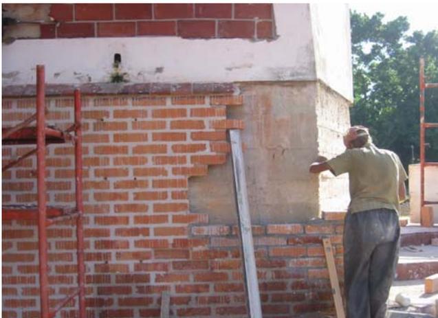
Fig. 7 – Particolare del muro in calcestruzzo nascosto dalla muratura
