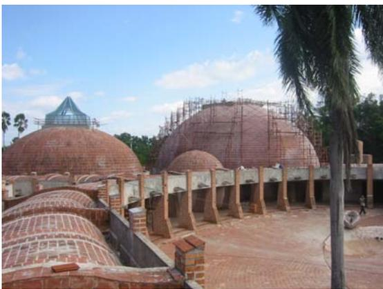
Fig. 9 – Vista sull'estradosso della volta catalana
