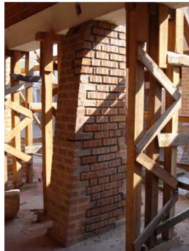
Figura 51 – Inserimento di mattoni nuovi per la listatura dopo l'inserimento del c.a.
