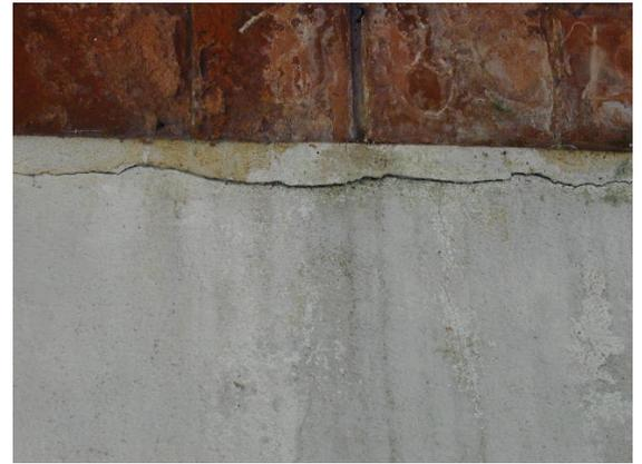
Fig. 47 – Lesione nella zona di imposta della volta
