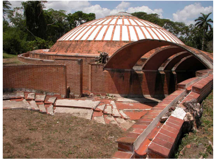
Fig. 23 Ballet, bóvedas y muros.
