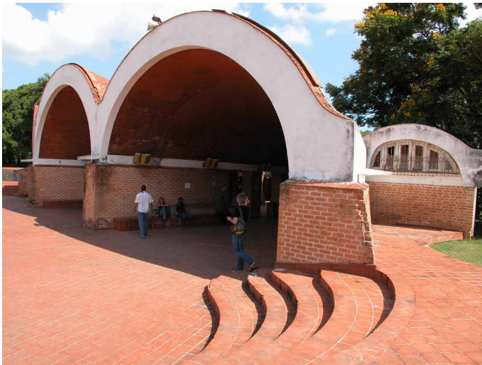
Fig. 7 Artes Plásticas, vista del interior hacia la entrada.
