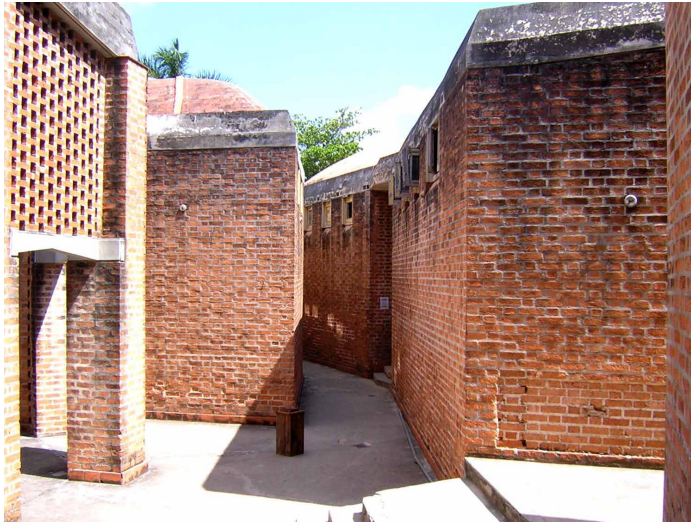
Fig. 20 Artes y Escénicas, muros y celosías.
