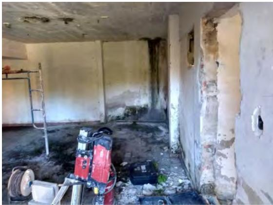
Humedad por absorcion en muros interiores
