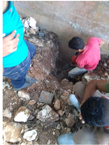
Punto de excavación
