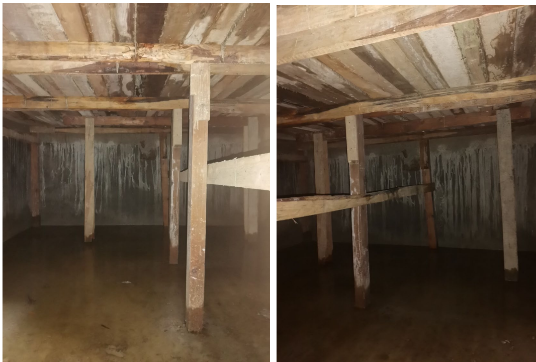
Img 3 y 4. Imágenes del pase interior del tanque séptico.
