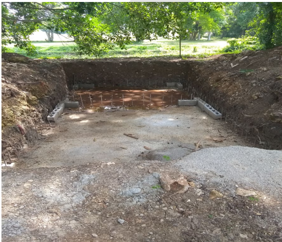
Excavación del tanque
